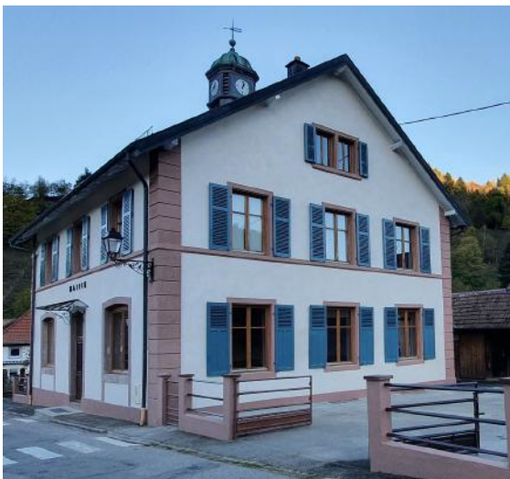
Ravalement de façade Mairie Storckensohn 2022
