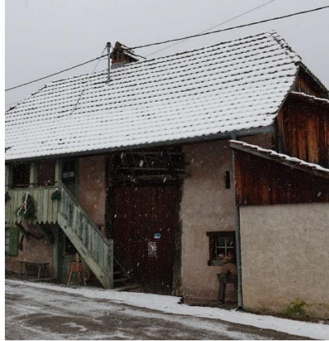
La maison Munsch est la plus ancienne du village. Elle accueille la maison de l'ouvrier-paysan. Elle pourrait faire l'objet de travaux de rénovation. Photo François Froehly
