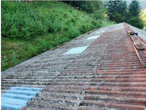
État du toit de l'étable avant travaux
