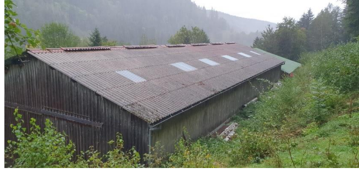
toit après les travaux
