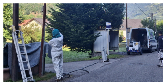
Sablage, primaire et 2 couches de finition sur les lampadaires
